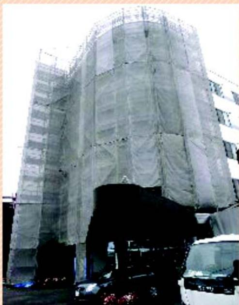
平成2年に建てられた森松本社ビルも、20年の歳月を経るとあちこち問題が出てきます。数年前から、各フロアの南側窓に近い天井から雨漏りが発生し、さらにこれまで暴風雨の時だけ発生していた雨漏りが、普通の雨でも起こるような状況でした。補修には外壁のパネルの目地を再シールする必要があるため、ご覧の様に足場を全面に組んで作業します。7月前半は雨が続いたので果たして予定工期内に完了するか？なんとか台風が来る前に完了して欲しいと願っております。
